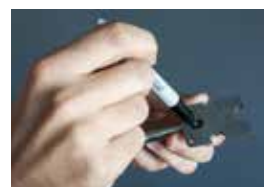
Markeer de pijp met behulp van de inspectiemeter.
